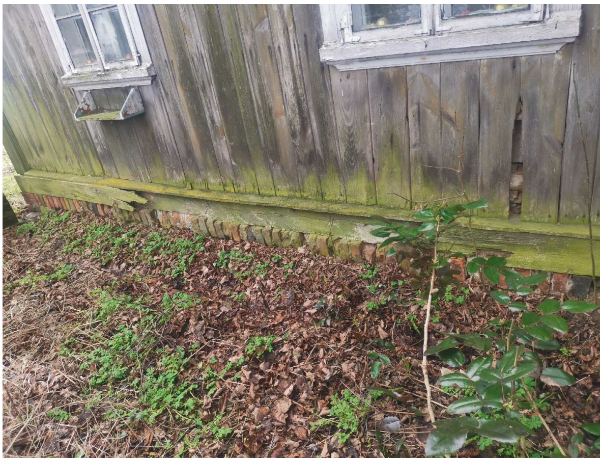
Rys6. Widoczne uszkodzenia podmurówki i podwalin
