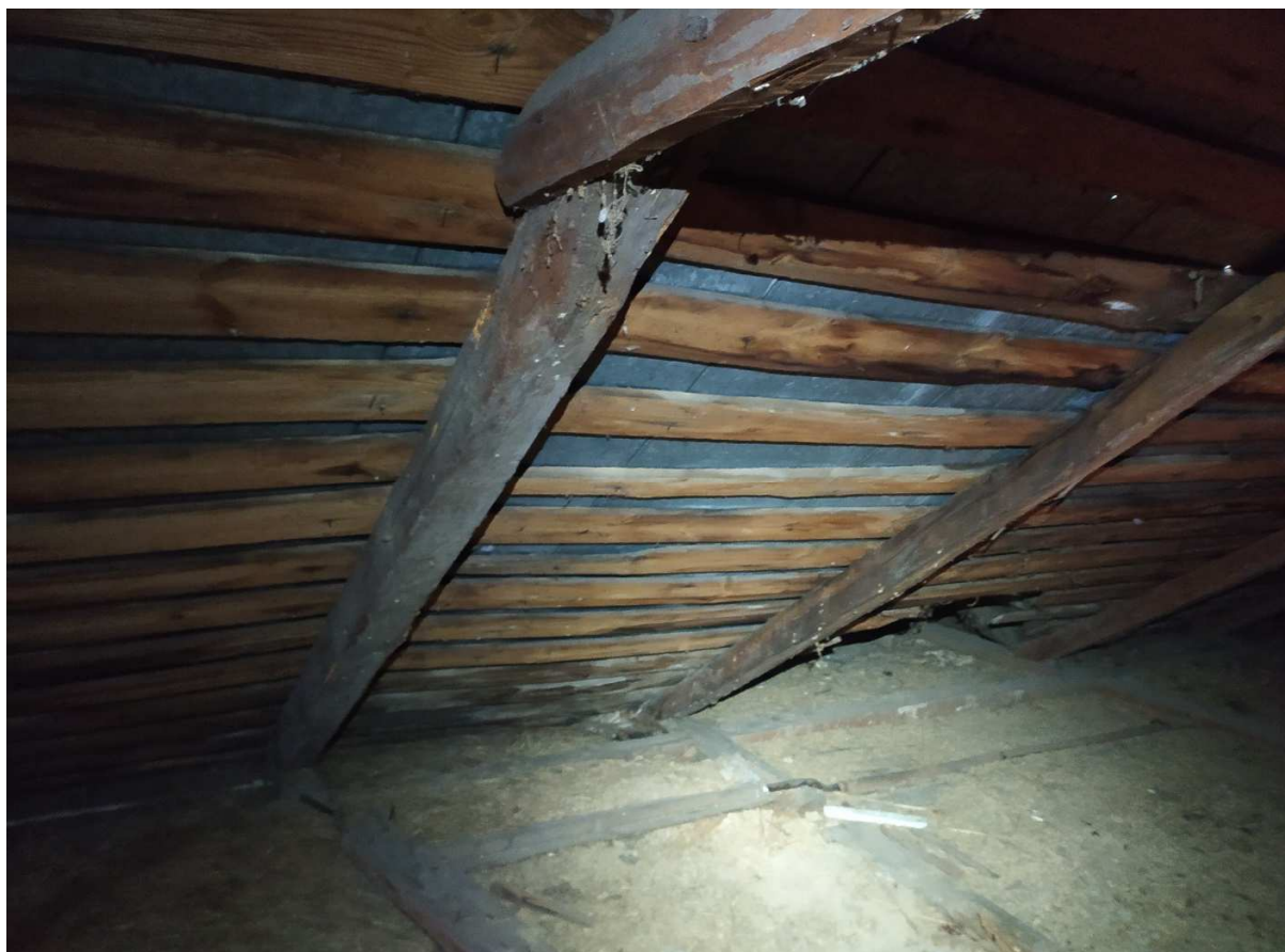
Rys8. Krokwie wraz z deskowaniem
