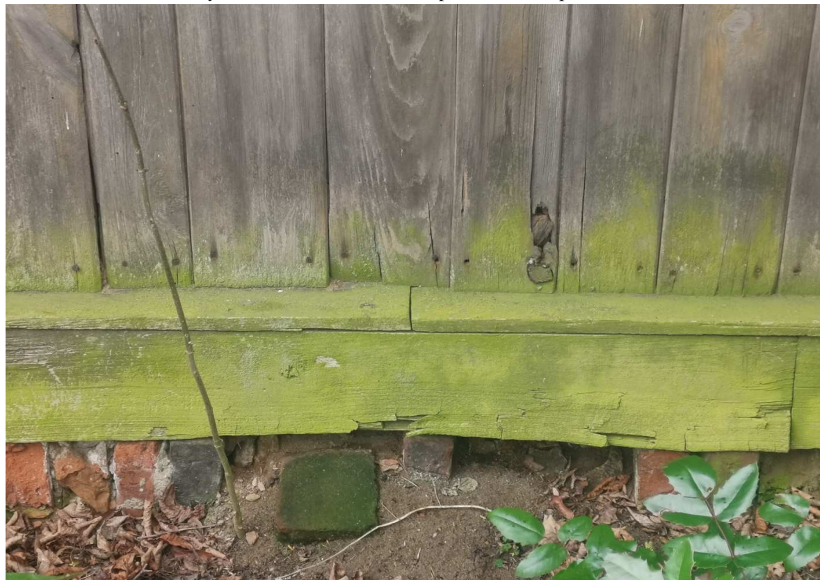
Rys7. Widoczne uszkodzenia podmurówki i podwalin
