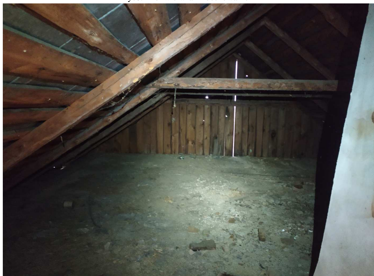
Rys9. Dach krokwiowo jętkowy
