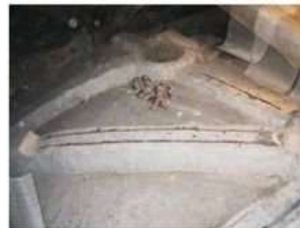
Od lewej: Naprawa zarysowanego sklepienia przy pomocy zszycia rys (FOT. 3); Przykład naprawy sklepienia przez zszycie ukośne (FOT. 4); Przykład naprawy żeber sklepienia przez zszycie podłużne (FOT. 5); fot.: Budosprzęt
