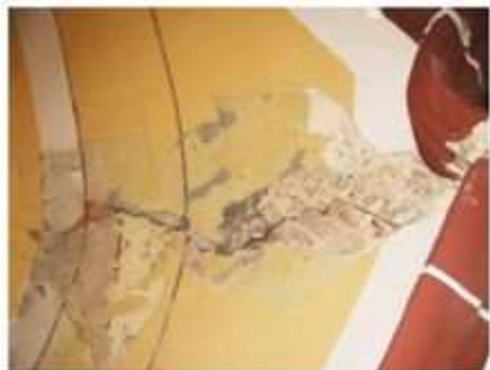
Od lewej: Naprawa zarysowanego sklepienia przy pomocy zszycia rys (FOT. 3); Przykład naprawy sklepienia przez zszycie ukośne (FOT. 4); Przykład naprawy żeber sklepienia przez zszycie podłużne (FOT. 5); fot.: Budosprzęt
